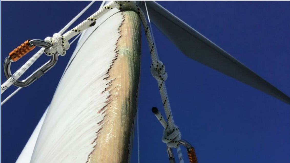
Vindkraftverket på Lista utsettes for kraftig nedbør. Operatøren Fred Olsen Renewables har funnet erosjon flere av turbinene. Karabinkroken til venstre i bildet gir en indikasjon på størrelsen på skaden. Skadene er nå utbedret. (Foto: Fred Olsen Renewables)
