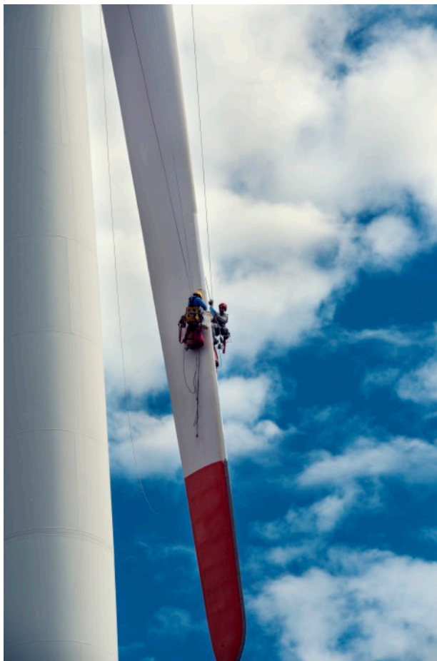
Reparasjon av turbinvinge, med sliping og pålegging av ny epoxy, uten synlig utstyr for å samle opp slipestøvet. (Bulgaria 3. sept. 2020). Foto: iStock.com / payamona
