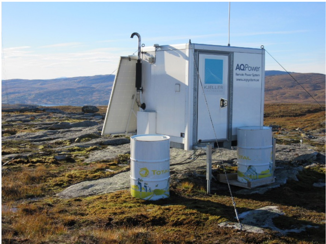
Geitfjellet Vindkraftverk, september 2015: To tønner olje er lagret ved siden av en vindmålemast på fjellet. Tønnene er bare satt rett på bakken uten noen beskyttelse. Lekkasje fra uhell, uvær eller tilfeldig sabotasje kan lett forårsake en betydelig oljelekkasje. Foto: Sveinulf Vågene
