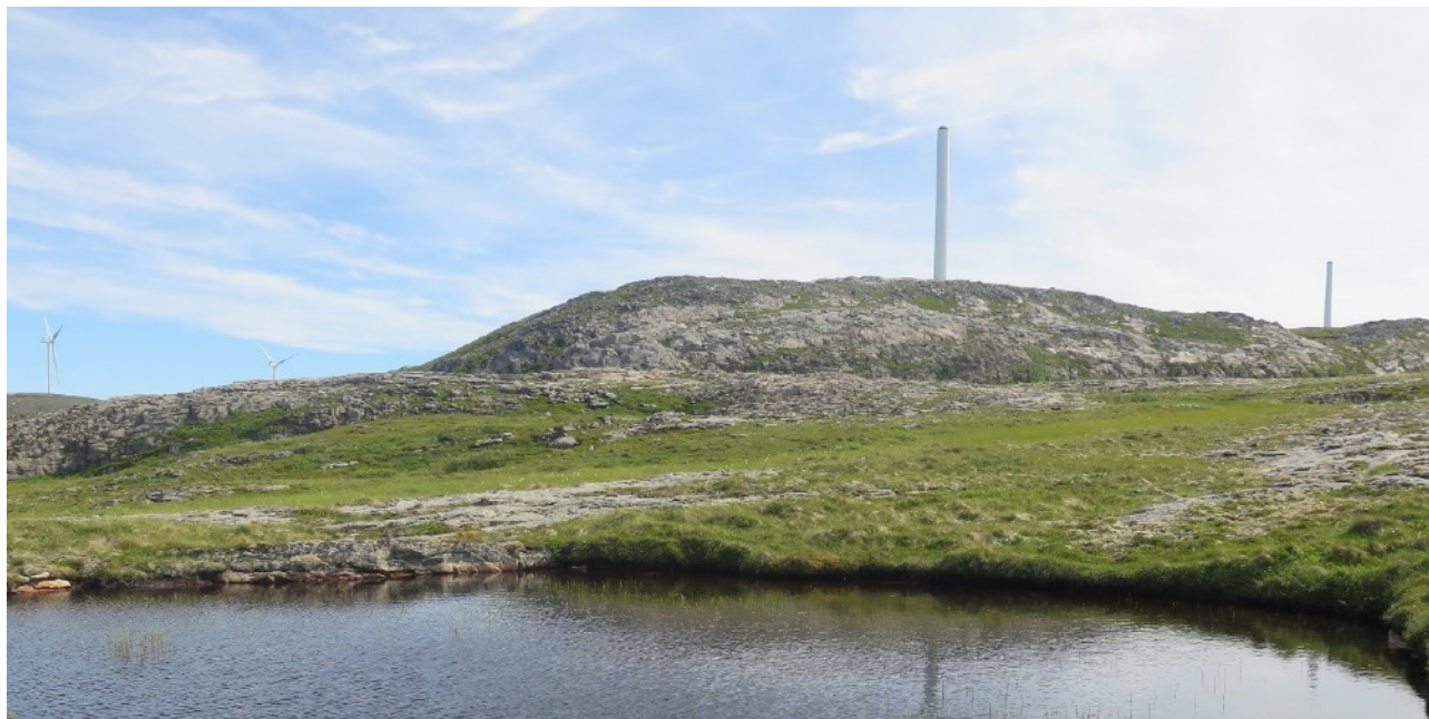
Fig. 1: Kystlynghei på Harbakkfjellet med vindturbiner under oppsetting. Foto: Ingerid Angell-Petersen
