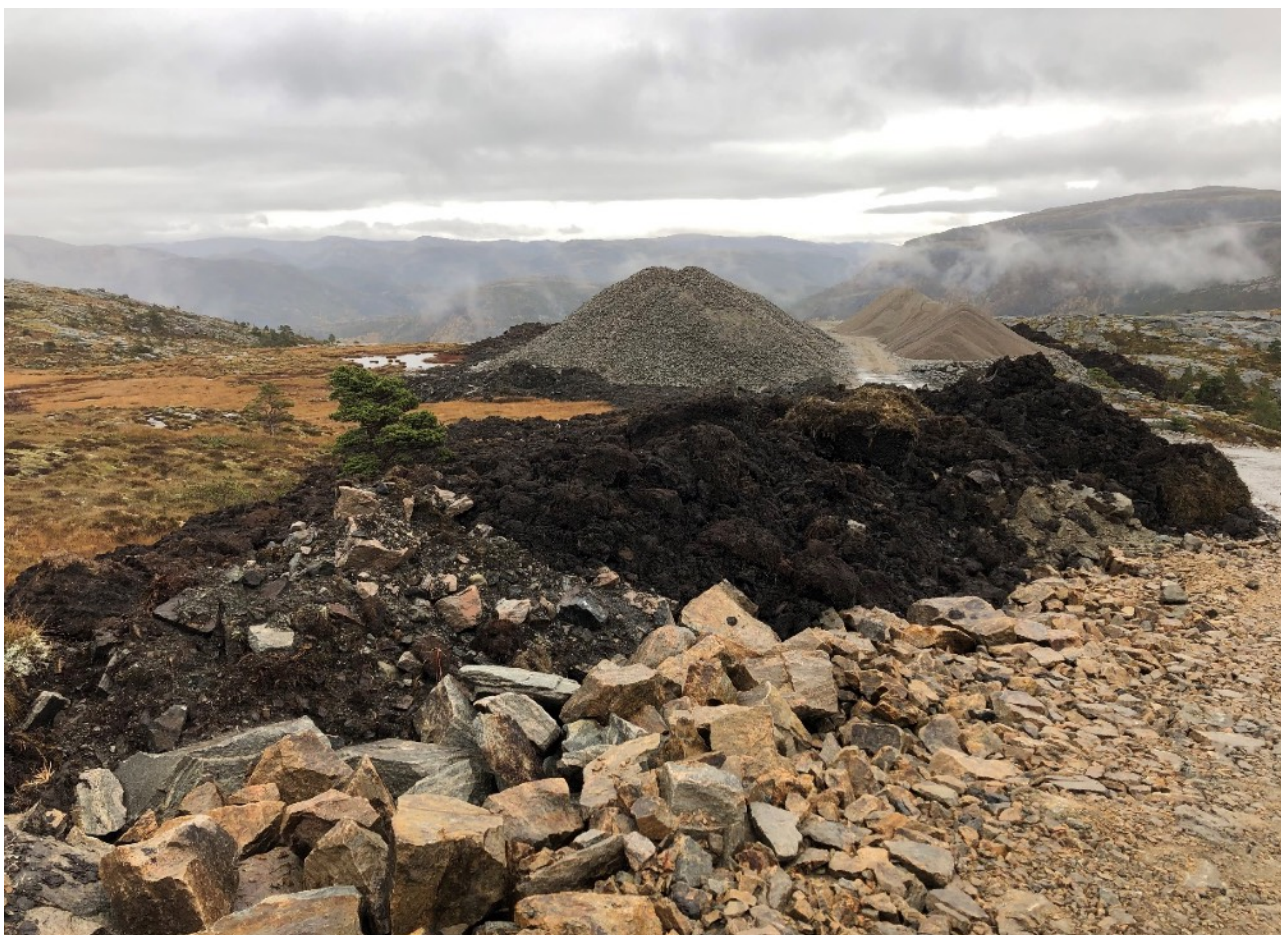
Fig. 8: Endevendt myr under bygging av vindkraftverket på Sørmarkfjellet, Fosen i Trøndelag. Foto: Kari Merete Andersen
